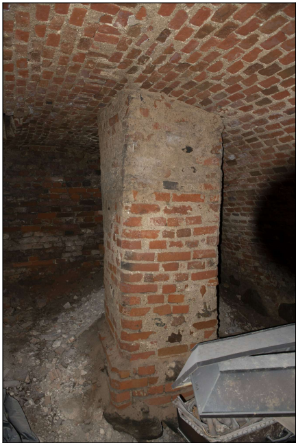
S-21 - rūšio patalpos P dalyje raudonų plytų mūro stulpas
