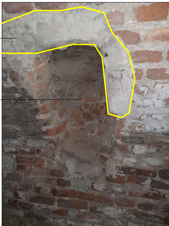
Betoninė sąrama ir angokraštis permūrijami pilnavidurėmis molinėmis plytomis
