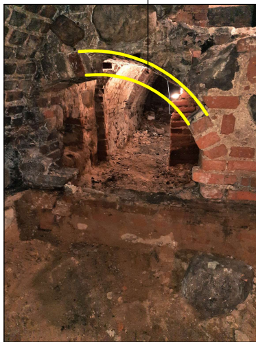
Laiptinės L3 polaiptinės nišos sąrama Š sienoje iš išorės
