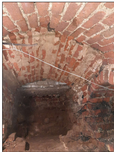
Laiptinės L3 autentiškas ir rekonstrukcinis skliautai
