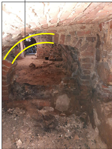
Laiptinės L3 polaiptinės nišos sąrama Š sienoje iš vidaus
