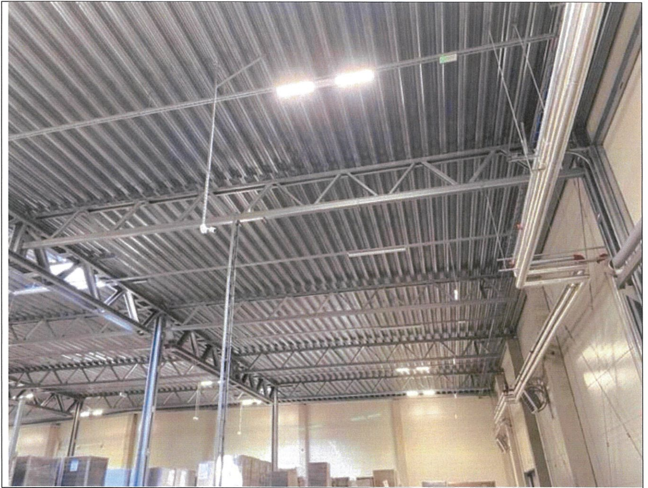
Pav.Nr.7. Sandėliavimo paskirties pastatų konstrukcijų vaizdas iš vidaus
