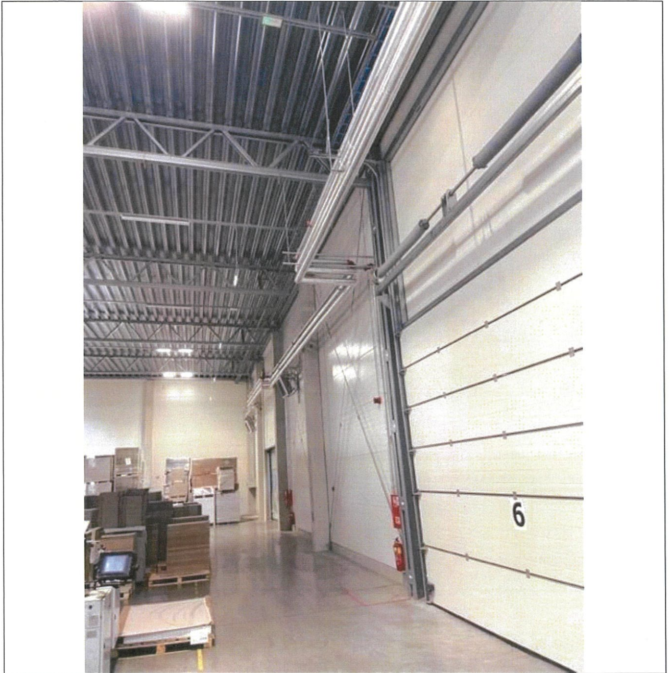
Pav.Nr.5. Sandėliavimo paskirties pastatų konstrukcijų vaizdas iš vidaus
